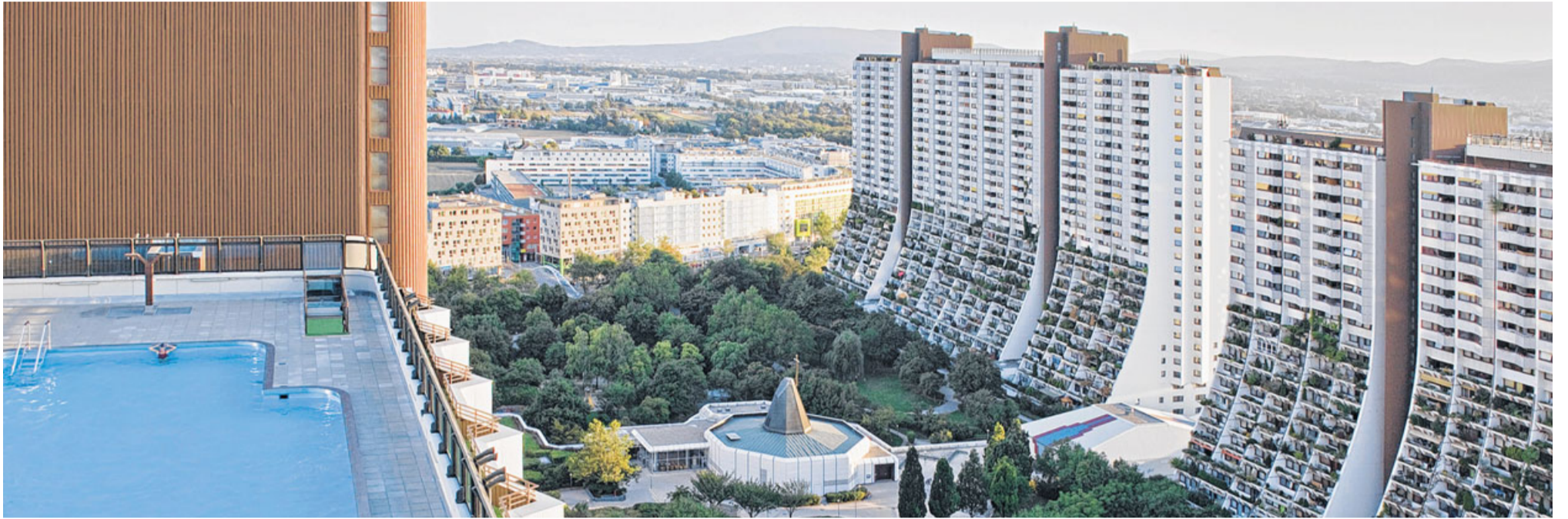
Swimmingpool am Dach und ein begrünter Balkon lassen die Bewohner offensichtlich die Fassade vergessen: Harry Glücks Bauten sind die beliebtesten in Wien. Foto: Hertha Hurnaus
