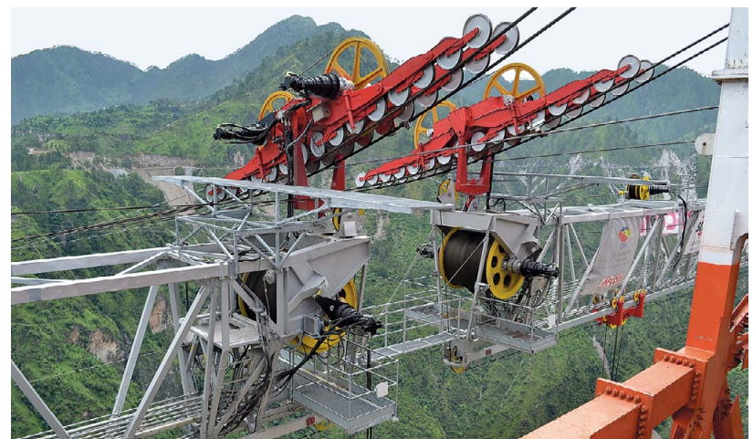
Der vom Wiener Ingenieurbüro VCE um DI Robert Schedler entwickelte Kabelkran für den Bau der höchsten Eisenbahnbrücke der Welt steht im Himalaja in Indien. Die Stahlkonstruktion hat eine Gesamtlänge von 1.350 Metern.
